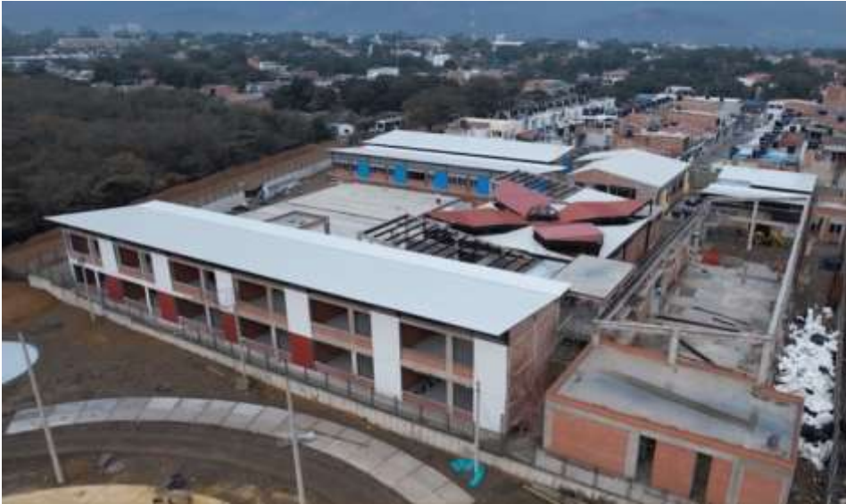
Se dio continuidad a las acciones orientadas a la construcción de infraestructura educativo
