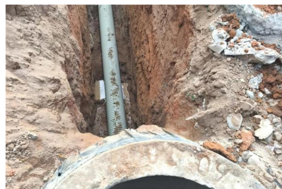
Excavación e instalación tubería Colinas de la Victoria
