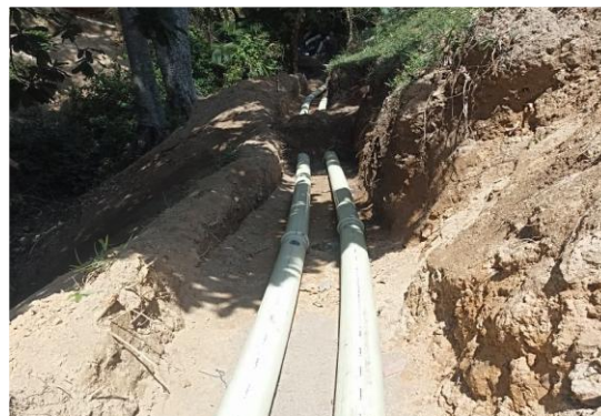
Colocación de tubería de aducción
