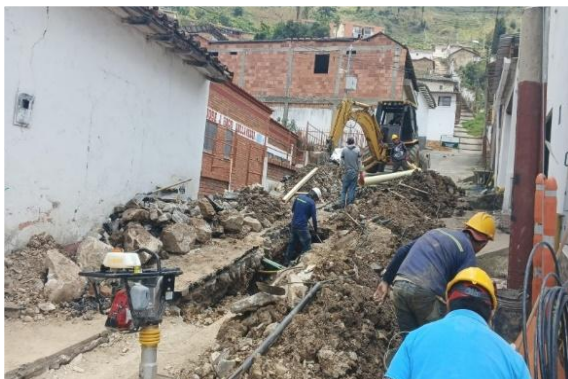
Excavación para optimización de red de acueducto y alcantarillado
