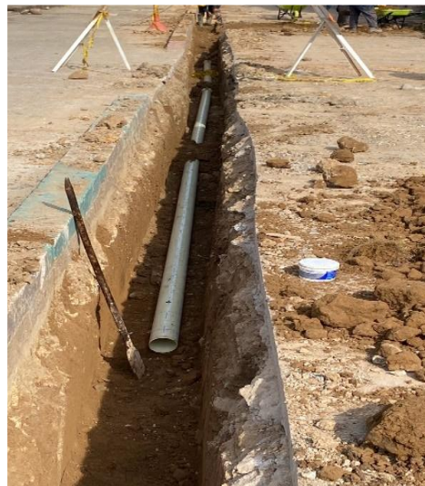
Colocación de red de distribución Puerto Santander
