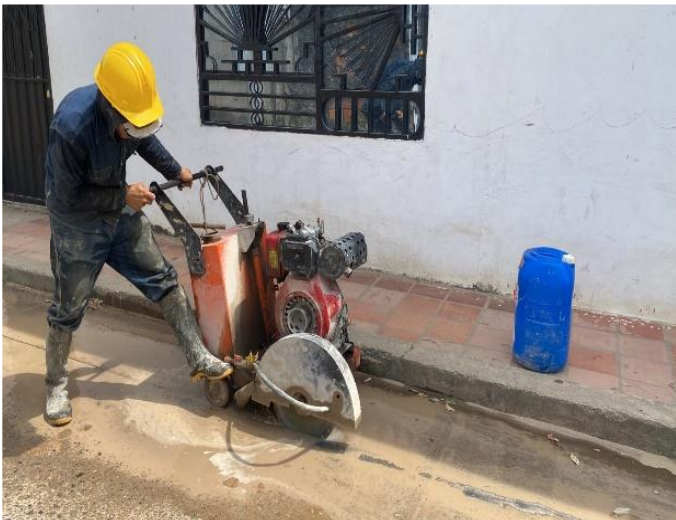
Corte de pavimento para realizar la excavación
