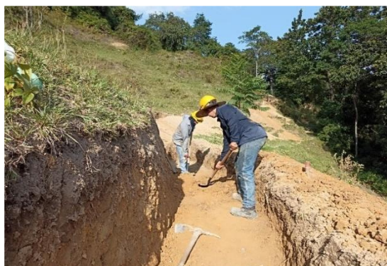
Excavación de material para colocación de tubería de aducción a la planta
