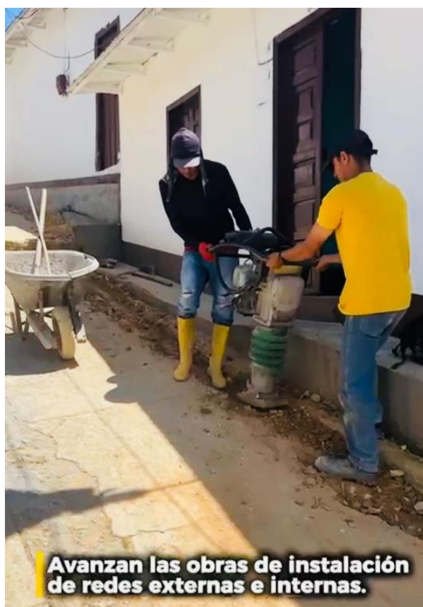
Foto N°23. Instalaciones de red interna de gas Municipio de Bucarasica.
