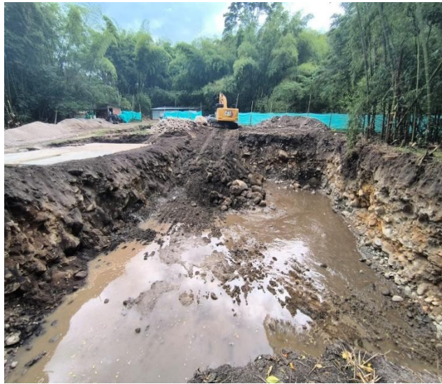
Avance de la excavación para la construcción de la planta de tratamiento de aguas residuales
