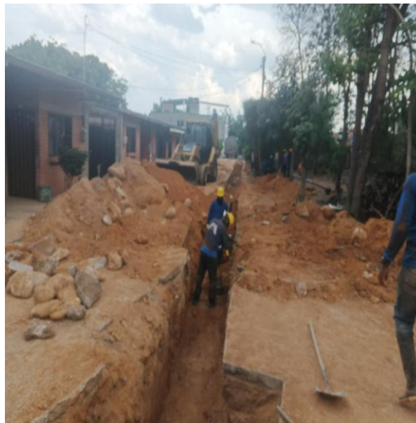
Excavación para la colocación de tubería Barrio las colinas
