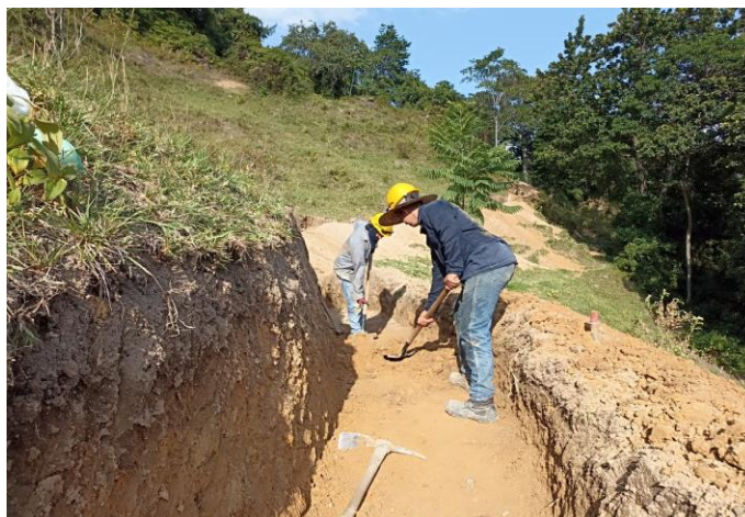
Excavación de material para colocación de tubería de aducción a la planta
