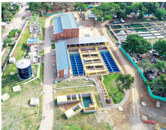
Nueva Planta de tratamiento el Pórtico
