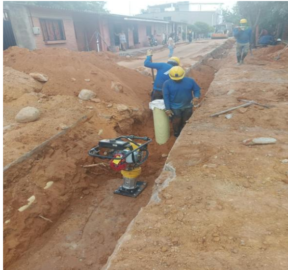
Compactación del suelo una vez colocado la tubería, Barrio las Colinas
