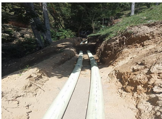
Colocación de tubería de aducción
