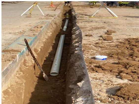
Colocación de red de distribución Puerto Santander
