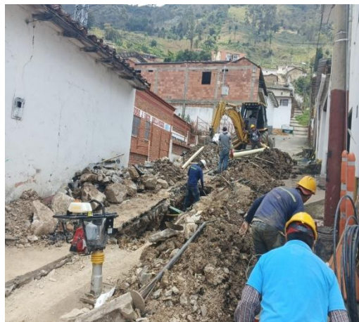
Excavación para optimización de red de acueducto y alcantarillado
