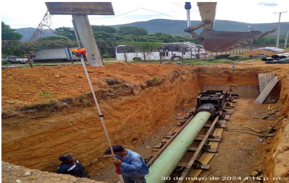
Cambio de tubería Municipio de Villa del Rosario
