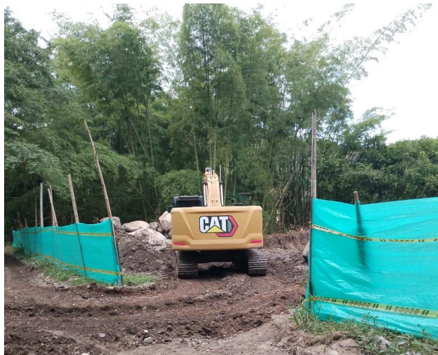
Excavación de material para la construcción de la planta de agua residuales de Bochalema
