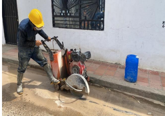
Corte de pavimento para realizar la excavación
