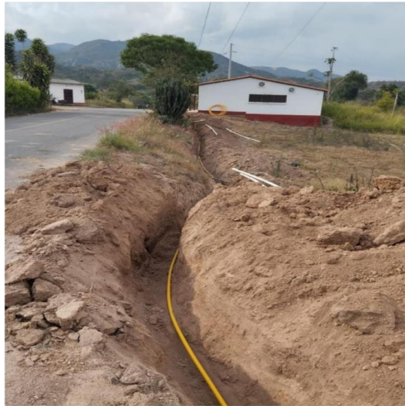
Foto 1. Instalaciones de red interna de gas Municipio de La Playa de Belén.
