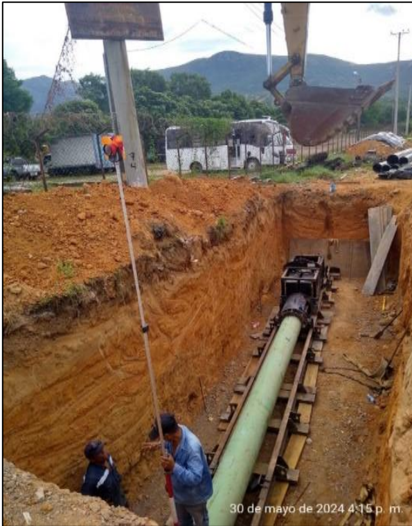
Colocación de tubería en Villa del Rosario
