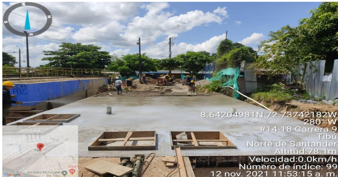
Construcción tanque de almacenamiento semi enterrado.
