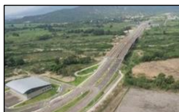
Puente Internacional Atanasio Girardot (Tienditas)
