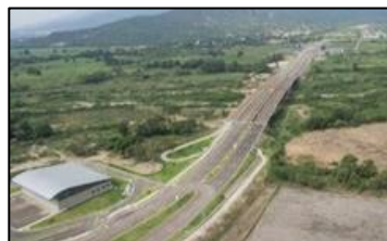
Puente Internacional Atanasio Girardot (Tienditas)
