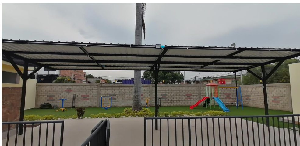
ADECUACIÓN Y DOTACIÓN PISCINA ATALAYA, MUNICIPIO DE CÚCUTA
