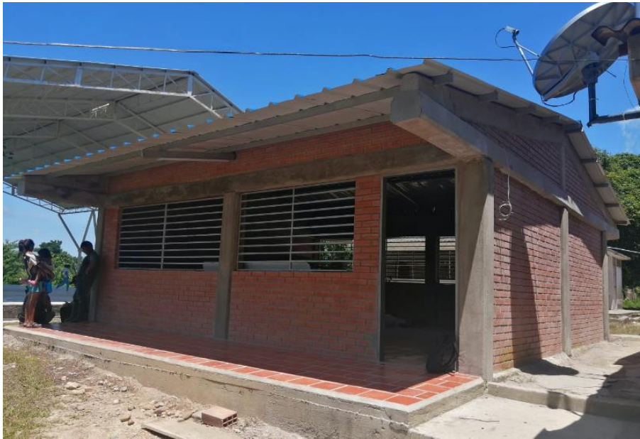
CONSTRUCCIÓN Y DOTACIÓN DE UN AULA ESCOLAR EN LA INSTITUCIÓN ETNOEDUCATIVA BARÍ LA MOTILONA SEDE PRINCIPAL RESGUARDO INDÍGENA CATALAURA TIBÚ
