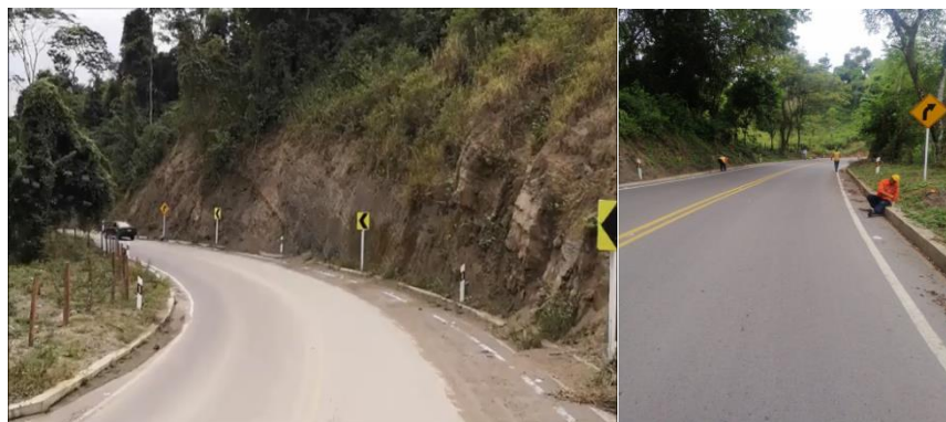
MEJORAMIENTO TRAMO DE LA VIA PTE GOMEZ - SALAZAR DEL K 14+710 AL K 16+870 SALAZAR NORTE DE SANTANDER
