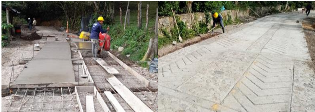
CONSTRUCCIÓN DE PLACA HUELLA EN LA VÍA QUE CONDUCE A LA VEREDA LA COLORADA PARTE ALTA, MUNICIPIO DE CHINÁCOTA
