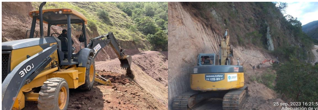
MANTENIMIENTO CORREDOR VIAL EL TARRITA-VEREDA EL RAMO- PUERTO RICO
