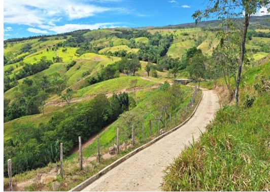
CONSTRUCCIÓN DE PLACA HUELLA EN LA VEREDA LA MACARENA - EL ZULIA - NORTE DE SANTANDER
