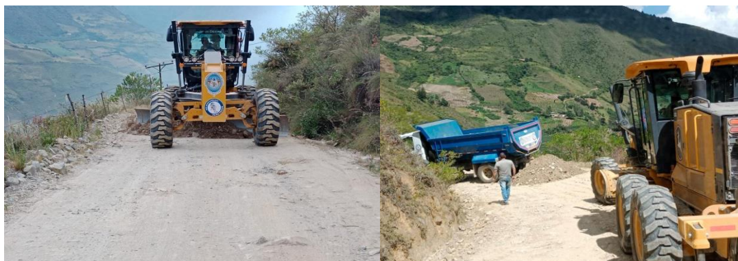
MANTENIMIENTO CORREDOR VIAL SILOS BAÑERA
