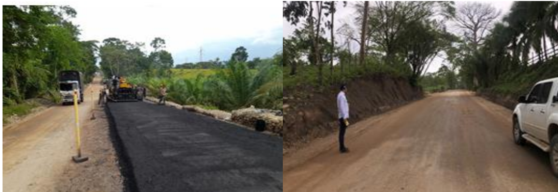
MEJORAMIENTO DE LA VÍA ASTILLEROS-TIBÚ TRAMO PR 31+845- PR 33+445, NORTE DE SANTANDER
