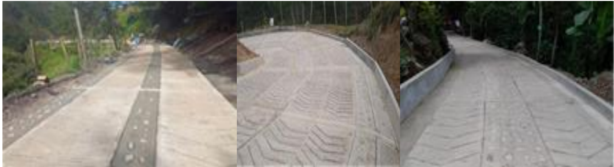
CONSTRUCCIÓN DE PLACA HUELLA EN OTROS MUNICIPIOS
