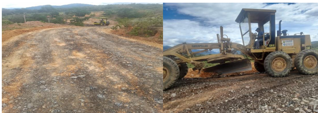
MANTENIMIENTO POR EMERGENCIA VEREDA EL TABIRO SAN CAYETANO
