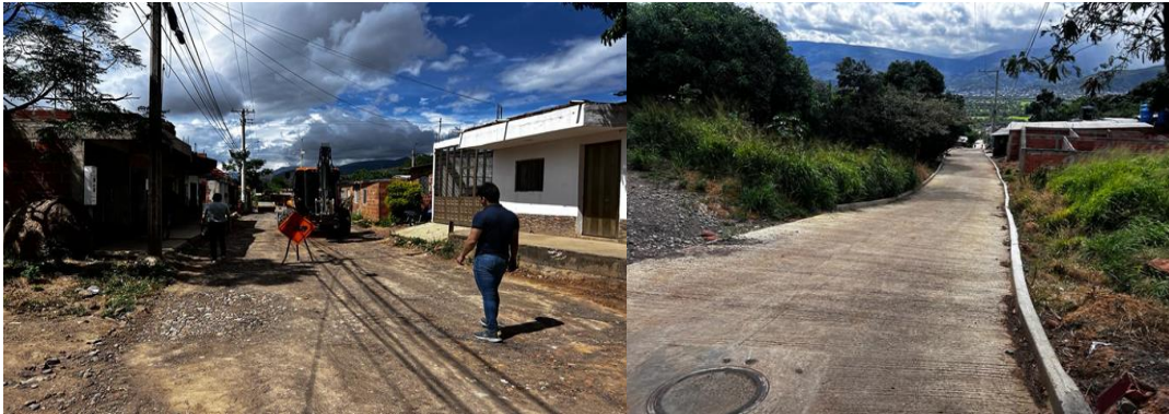
CONSTRUCCION PAVIMENTO RIGIDO VIAS URBANAS, MUNICIPIO DE VILLA DEL ROSARIO,
