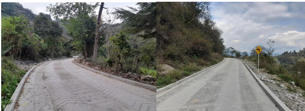
CONSTRUCCION DE PLACA HUELLA EN LA VEREDA Balsa DEL MUNICIPIO DE LABATECA, DEPARTAMENTO NORTE DE SANTANDER
