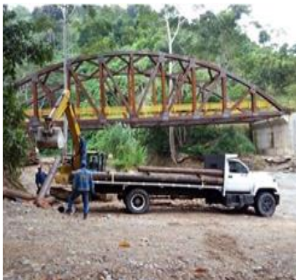
MEJORAMIENTO DEL ANILLO VIAL DE LA PAZ DEL CATATUMBO, CON LA CONSTRUCCIÓN DE CUATRO Puentes PRIORIZADOS, MUNICIPIOS DE HACARÍ, SAN CALIXTO Y EL TARRA
