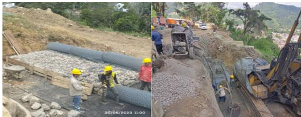
MEJORAMIENTO DE LA VÍA CHINÁCOTA RAGONVALIA K 0+000 - K 1+000 NORTE DE SANTANDER.
