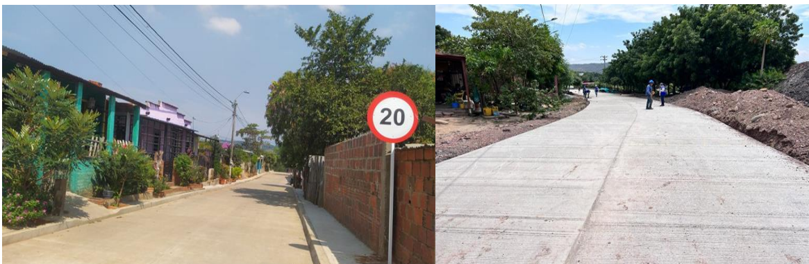
CONSTRUCCIÓN DE VÍAS EN CONCRETO RÍGIDO PARA EL MUNICIPIO DE SAN CAYETANO.
