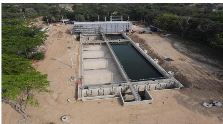
Subproyecto 1. Desarenador sector Termotasajero, San Cayetano
