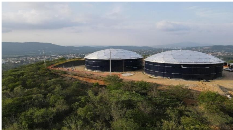
Subproyecto 4. Tanques de almacenamiento barrio Las Cumbres, municipio de Los Patios
