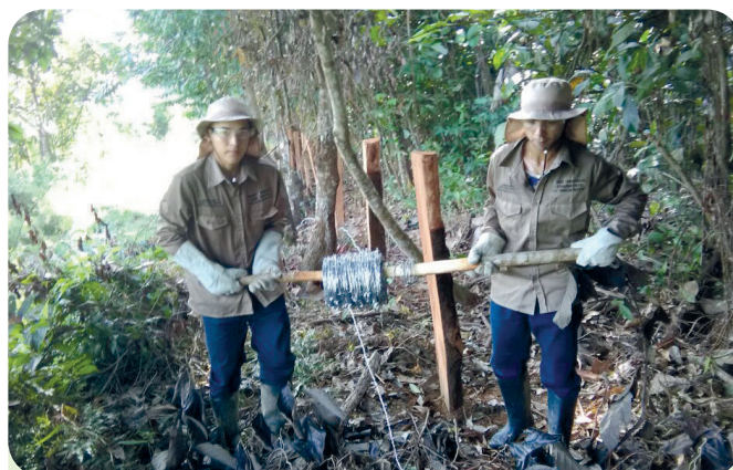
Construcción de aislamientos para mantenimiento de áreas estratégicas
