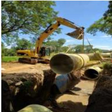
Instalación de 16 km de tubería subproyecto 1
