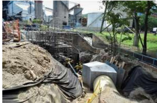
Construcción de línea de aducción de la captación al desarenador para el subproyecto 1 en la termoelectrica de Termotasajero (San Cayetano)
