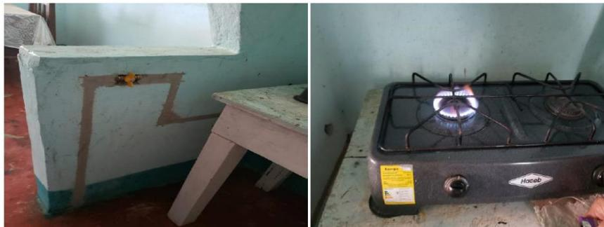
Foto No. 7. Instalación de red interna de la vivienda
