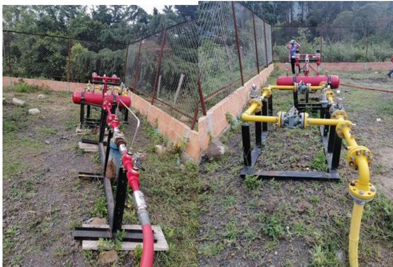
Foto No. 11. Sistema de válvulas de la estación de abastecimiento y servicio del Municipio de Herrán.
