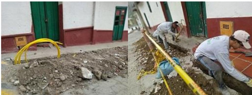
Foto No. 5. Trabajos de instalaciones de acometidas externas e internas en el Municipio del Carmen
