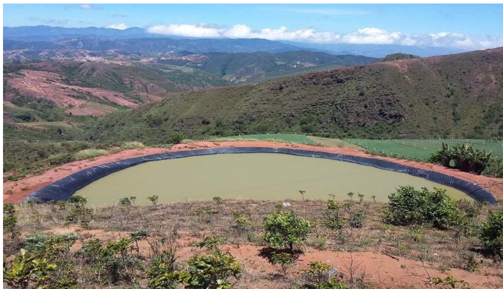
Adecuación reservorio Aso-Llano Verde – Municipio de Ocaña
