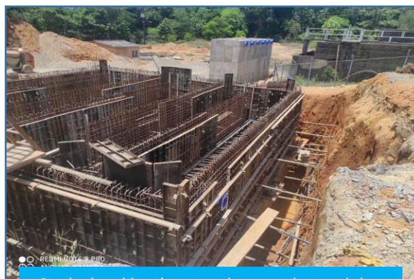
Optimización sistema de acueducto del corregimiento de La Gabarra, municipio de Tibú
