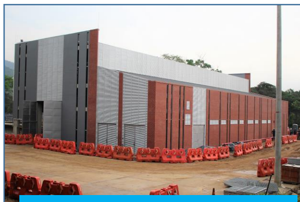
Vista externa de la estación de bombeo del desarenador de Termotasajero (subproyecto 1 AMFPS)
